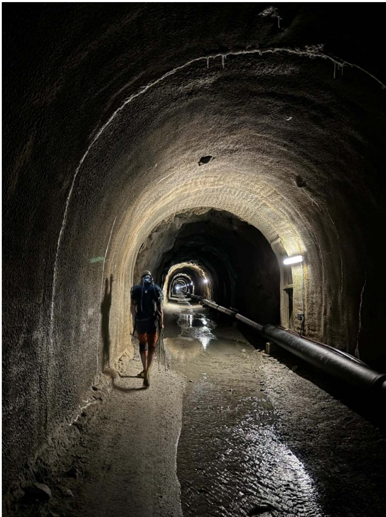
Pav. 5 Tälligrattunnel tunelis. (Linas Smalakys, 2024-07-22)
